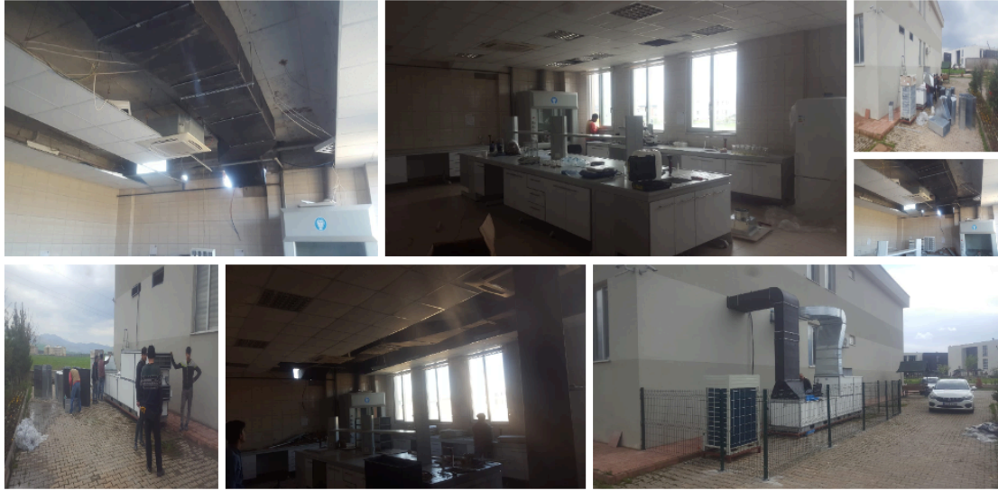
Şekil 6. Gıda analiz havalandırma sistemi.
